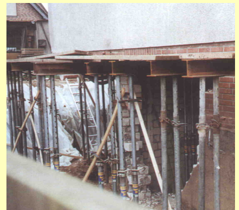
Ein durch Bergschäden zerstörter Keller wird erneuert
